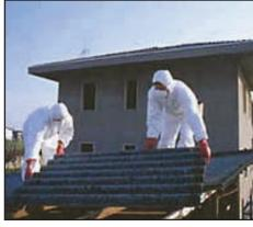
Le lastre in amianto - cemento vengono rimosse dalla copertura ad opera di personale addetto ed adeguatamente formato e in conformità alle procedure contenuto nel Piano di Lavoro.
