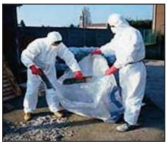
Tutti gli eventuali frammenti delle lastre rimosse vengono asportati mediante aspirazione con l'ausilio di aspiratori a filtro assoluto o raccolti ed inseriti in appositi sacchi per il trasporto.
